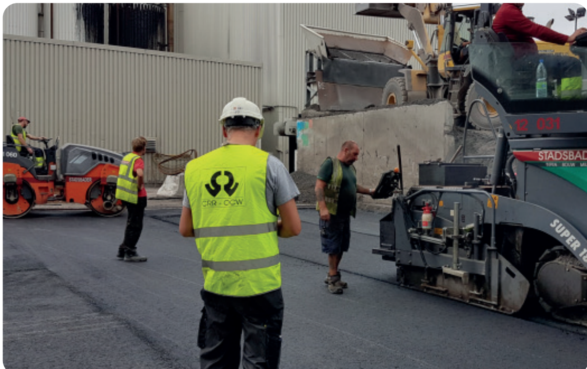
Mise en œuvre de réjuvenants dans les revêtements bitumineux
