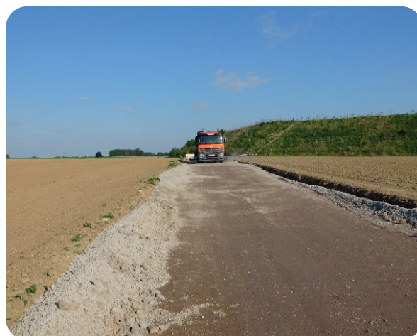
Exemple de fondation en produit de scalpage traité (recyclés mixtes 0/20 et 6% de ciment) mise en œuvre dans le cadre du projet RIDIAS (voir chapitre 6.5 Applications innovantes dans le secteur routier) et présentant une résistance en compression moyenne à 90 jours de 22.5 MPa.
