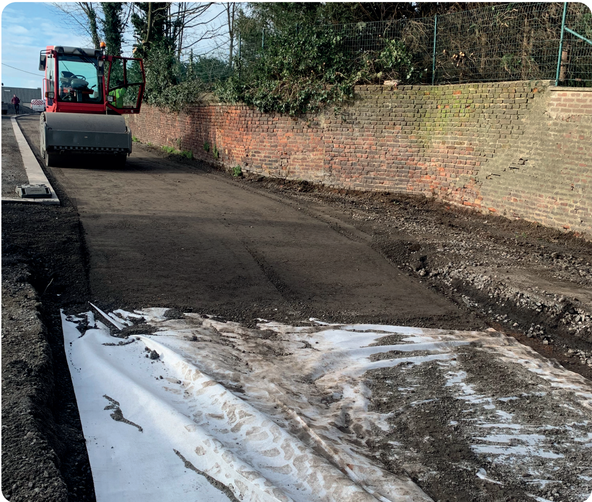
Mise en œuvre d'une fondation de voirie en granulats recyclés
