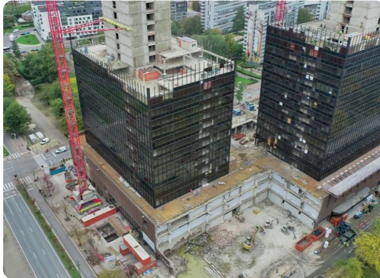
Projet ZIN à Bruxelles : granulats de béton issus de la démolition sélective des anciennes tours WTC
