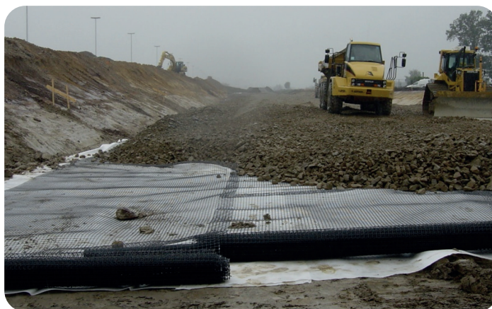
Mise en œuvre de granulats recyclés en plateforme de travail temporaire
