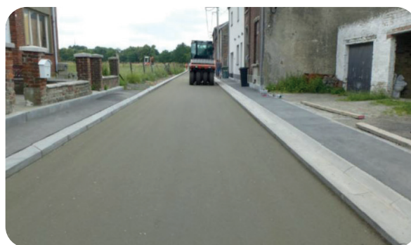
Compactage produit recycle (CRR)
