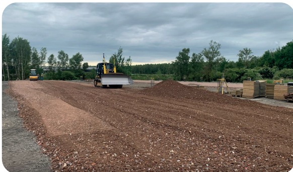
Illustrations de mise en œuvre de granulats recyclés en chantiers publics
