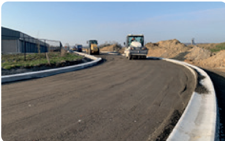
Mise en œuvre d'une fondation en béton maigre recyclé
