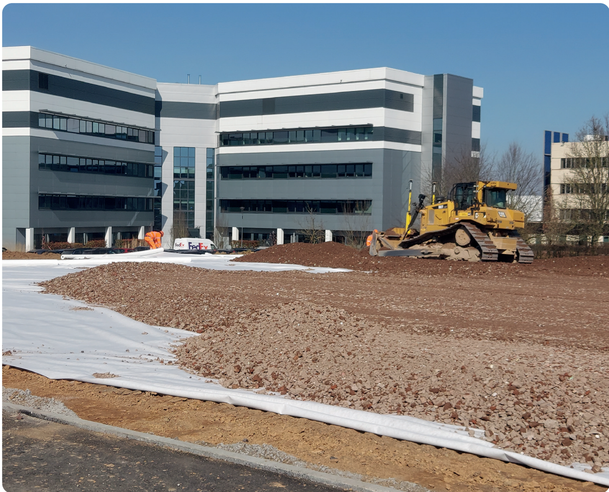
Mise en œuvre de granulats mixtes en sous-fondation
