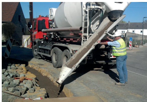
Exemple d'application du MAR en tranchée étroite
