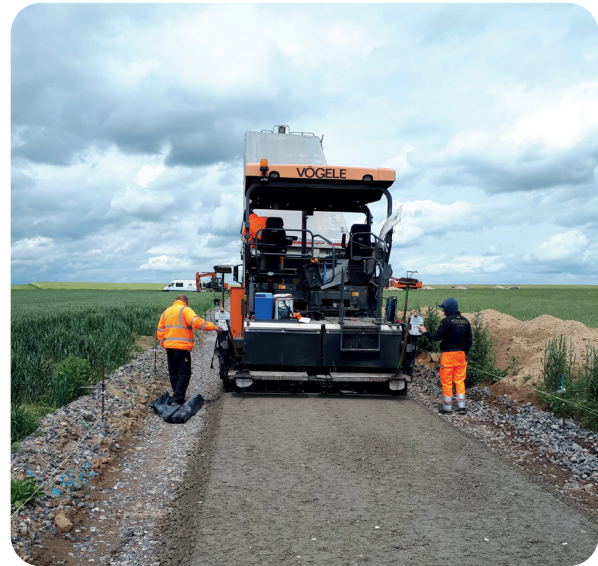
Aspect des deux BSC après mise en œuvre à la finisseuse
