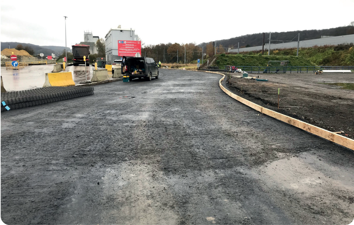
Mise en oeuvre d'une fondation en empierement recyclé
