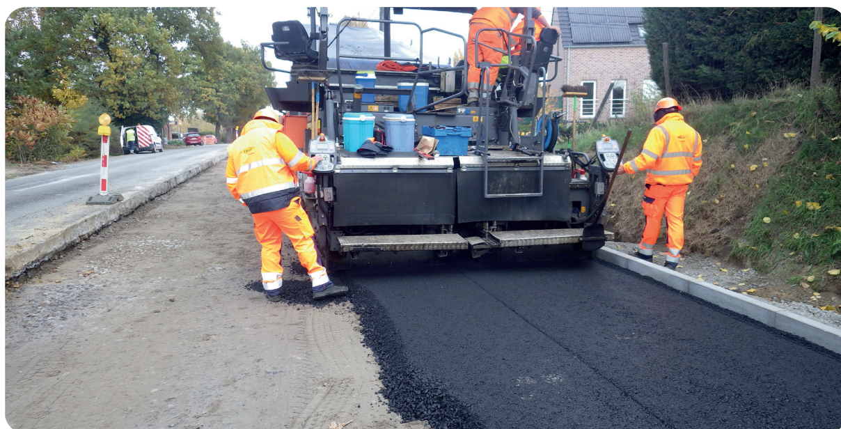
Fondation en grave bitume
