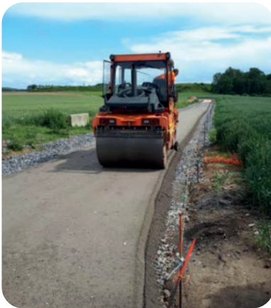
Compactage du BSC puis protection par épandage d'une émulsion de bitume et aspect final après simple gravillonnage
