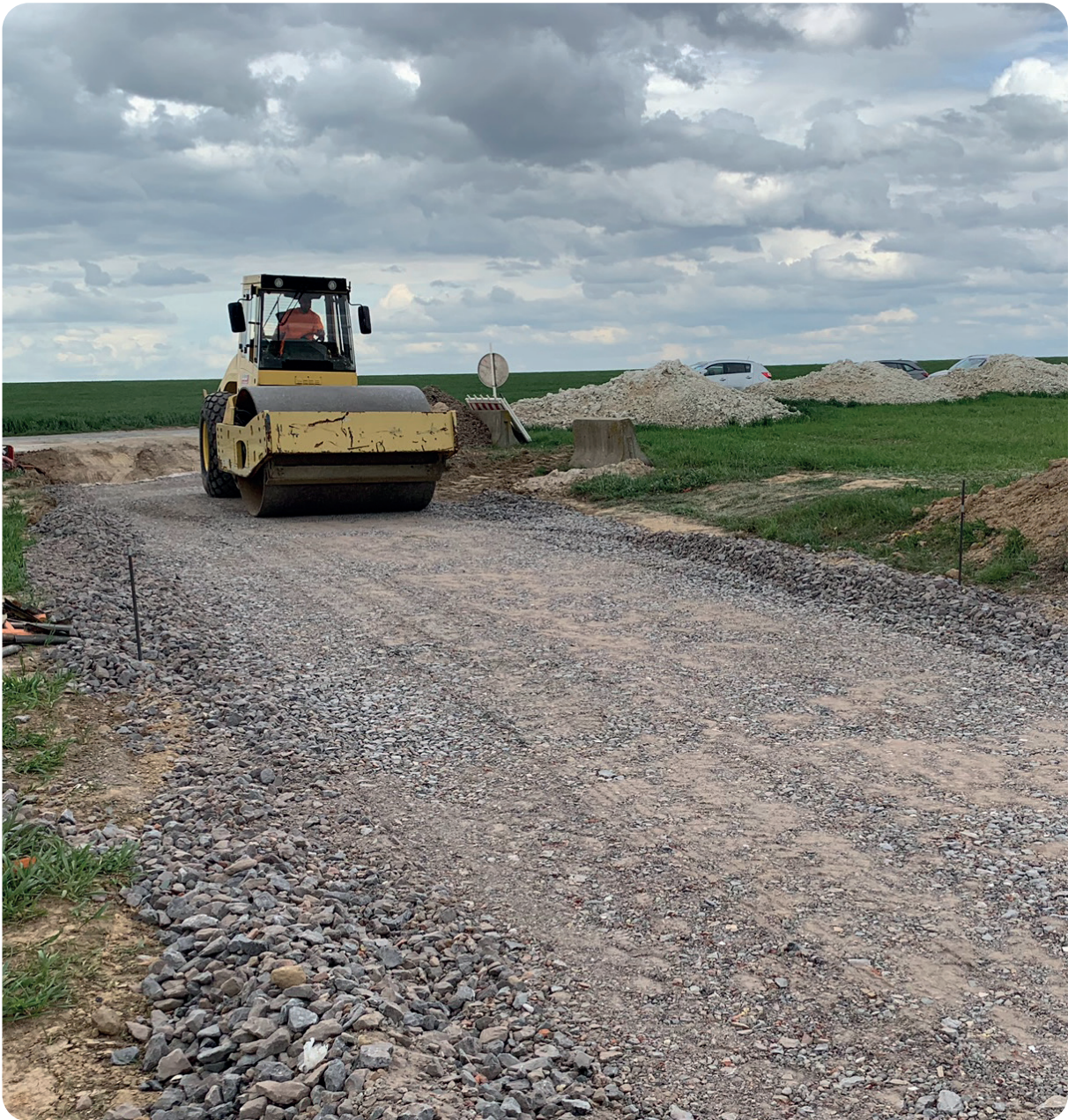
Mise en œuvre d'une fondation drainante en granulats recyclés (projet RIDIAS)
