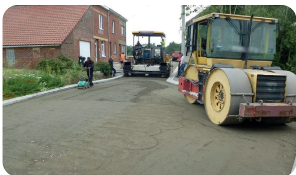
Compactage produit recycle (CRR)
