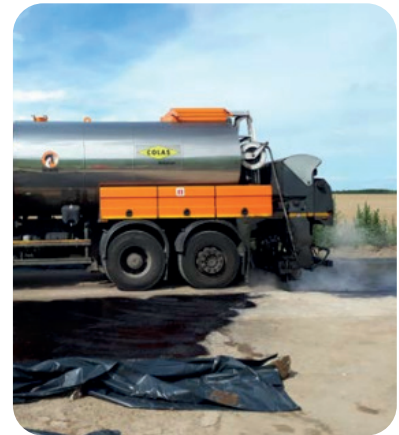
Compactage du BSC puis protection par épandage d'une émulsion de bitume et aspect final après simple gravillonnage
