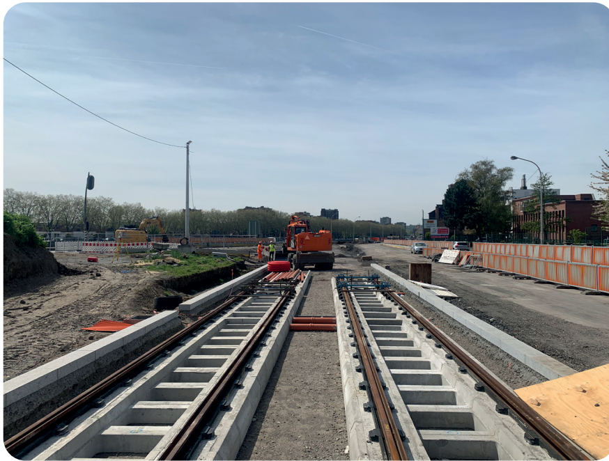
Mise en œuvre de fondation en empierrement recyclé
