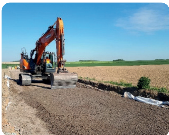
Exemple de fondation en produit de scalpage traité (recyclés mixtes 0/20 et 6% de ciment) mise en œuvre dans le cadre du projet RIDIAS (voir chapitre 6.5 Applications innovantes dans le secteur routier) et présentant une résistance en compression moyenne à 90 jours de 22.5 MPa.
