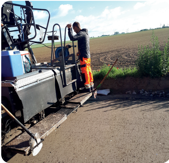
Aspect des deux BSC après mise en œuvre à la finisseuse
