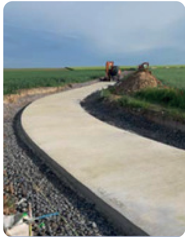
Mise en œuvre du béton riche et aspect après durcissement
