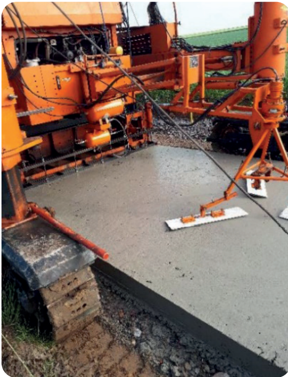
Mise en œuvre du béton riche et aspect après durcissement
