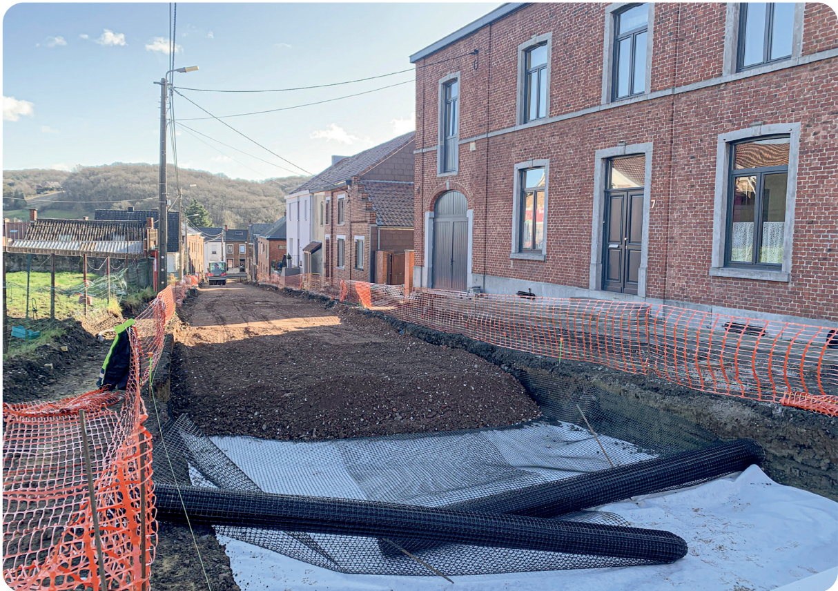
Application de granulats mixtes en sous-fondation routière
