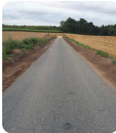
Compactage du BSC puis protection par épandage d'une émulsion de bitume et aspect final après simple gravillonnage
