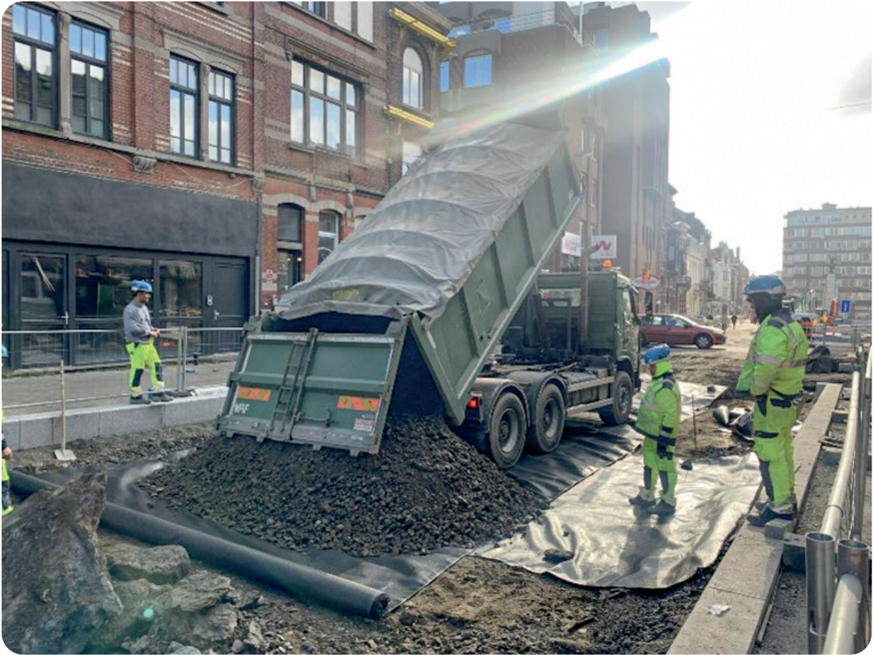
Mise en œuvre de granulats mixtes en sous-fondation de route
